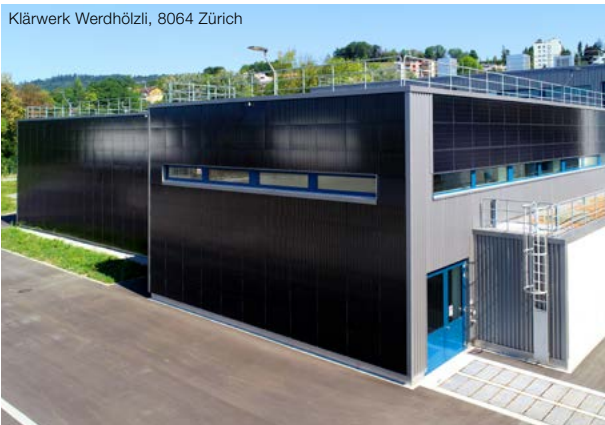
Klärwerk Werdhölzli, 8064 Zürich
